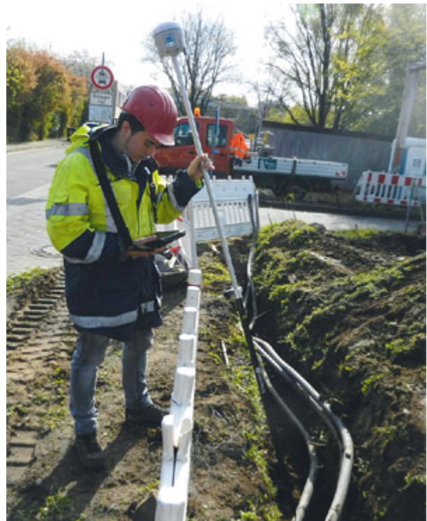
Anwendungsbeispiel Grabenvermessung: Der STONEX S10 kann schräg vom Rand an den Messpunkt geführt werden. Die Software berechnet dies automatisch mit. Bild: stonex
